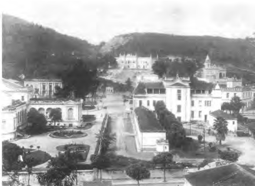
Figura 1 - Vista da Praça da República, com o Hospital Santa Cruz ao fundo, em fase final de construção - Arquivo da Sociedade Portuguesa de Beneficência de Niterói.
